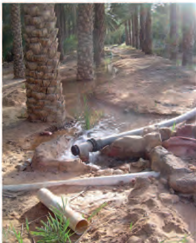
Irrigation à la rale sur la ligne
